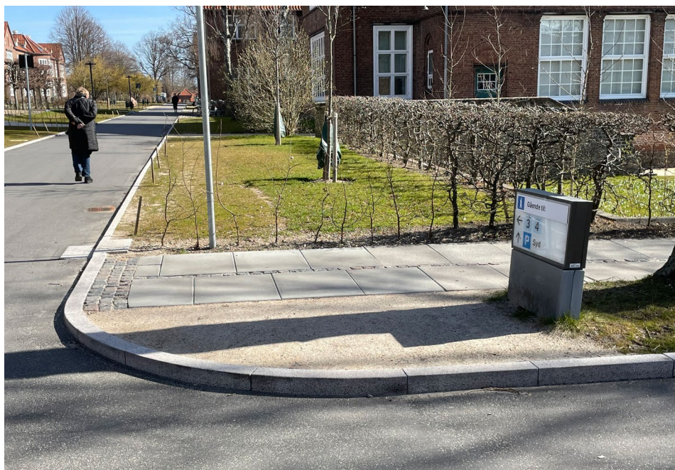
FIGUR 12 Manglende sammenhæng og dårlig tilgængelighed for gående. Foto: MOE
