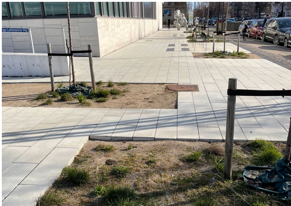
↑ FIGUR 16 Nyanlagt fortov på hjørnet af Blegdamsvej og Inge Lehmanns Vej. Fortovsfliserne fremstår lyse og af høj kvalitet, men forløbet af den integrerede begrønning bryder et direkte gangflow og mindsker fremkommeligheden for gangbesværede. Foto: MOE
