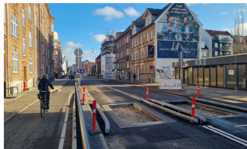
Ved overgangen til det snævrere del af Skibhusvej introduceres en sluse, som giver adgang for offentlig transport samt folk til fods og på cykel, men ikke for privatbiler. Fotoet ovenfor viser etableringen af en lignende sluse i Aalborg.
